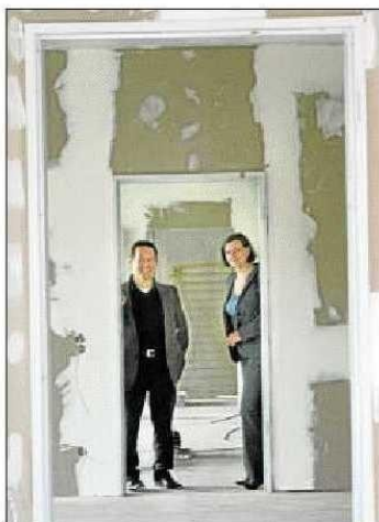
Über Türen verbunden: In einem der neuen Klassenräume - Uwe Schenk vom Landkreis und Karin Knobloch, Architektin von RSE.
