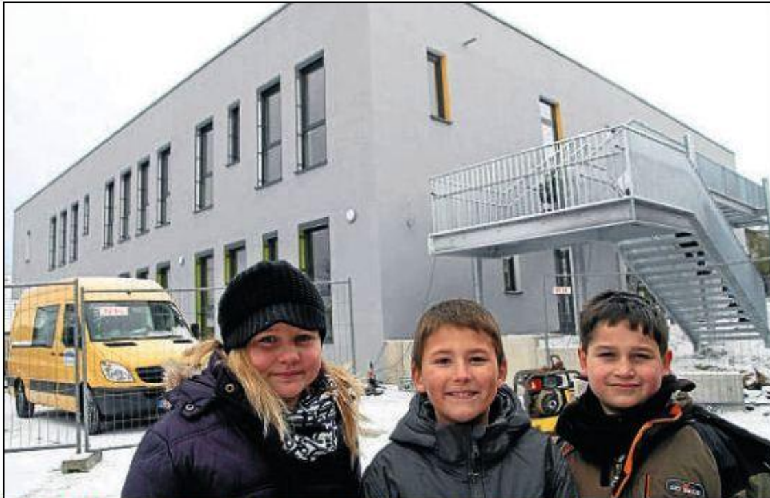
Freuen sich auf ihre neue Schule (Hintergrund): Katharina (von links), Jonas und Justin, die achtjährigen Schüler aus der Klasse 3b. Hinten rechts ist die an der Nordfassade neu angebaute Fluchtterze zu sehen.
