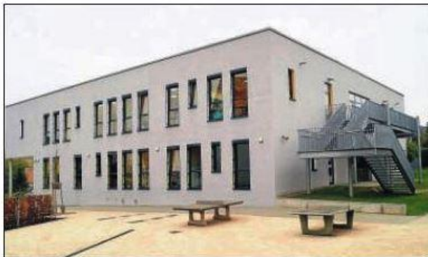
Neubau: Die Grundschule Simmershausen wurde im Jahr 2010 kernsaniert und ist damit auch räumlich neu aufgeteilt worden.
